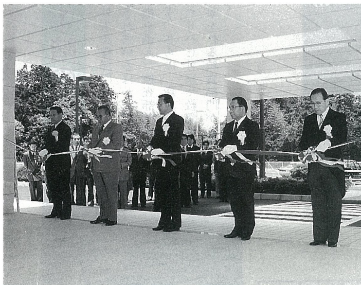
竣工を祝いテープカットをする関係者(写真上)と地域の中核医療機関として期待される新しい東陽病院(写真下)
