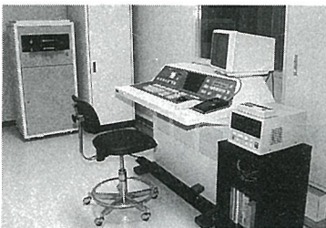
操作をするCT操作室(下)
