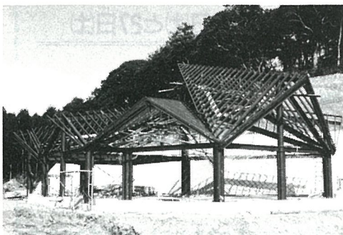
管理棟(センターハウス)
