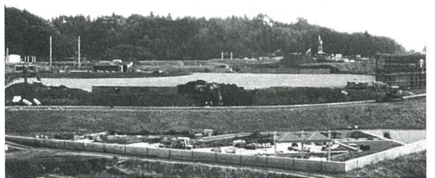
工事の進む光スポーツ公園
