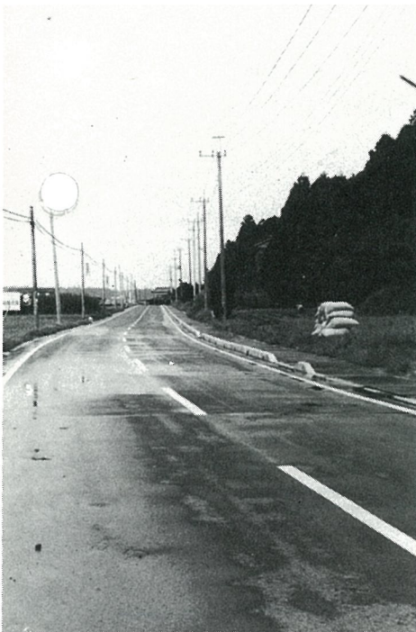
水銀灯を設置する県道
