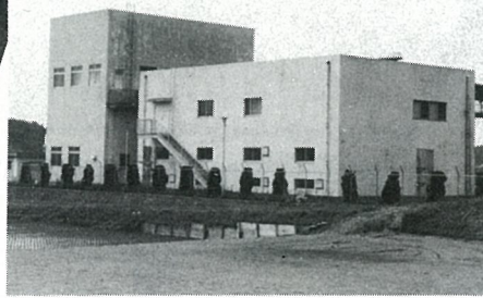
水を取水する宝米取水場
