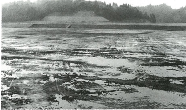
第一期の造成が完成した 光工業団地
