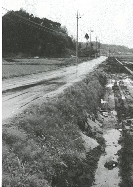
改良工事が行われる幹線道路 (小田部地先)
