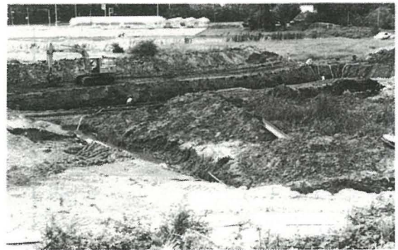
▲ 工事の進む調整池
