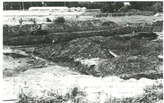
▲ 工事の進む調整池
