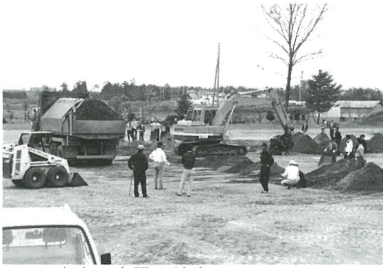
▲工事中の東陽小校庭
