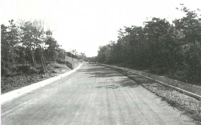
完成間近い海岸道路
