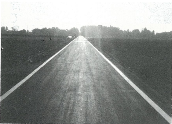
58年度 古屋・入線舗装新設工事
