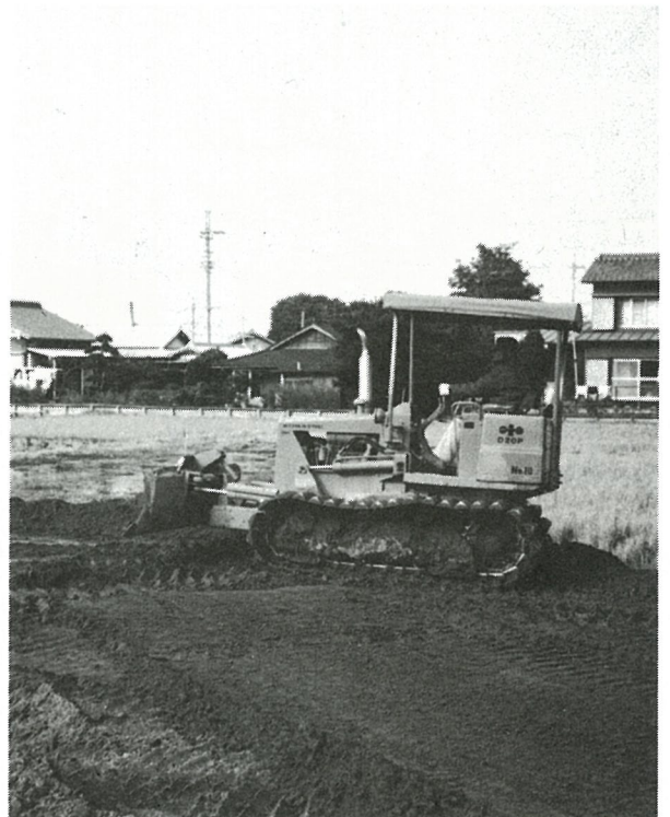
客土工事 篠本地先
