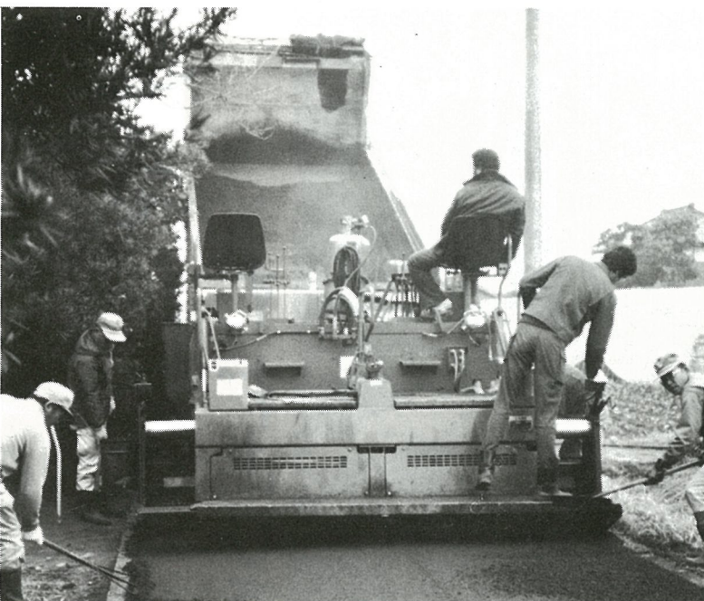
直営舗装工事 入地先
