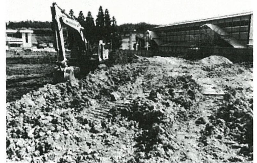
まちにまたれた日吉小学校の建設が始まりました。
