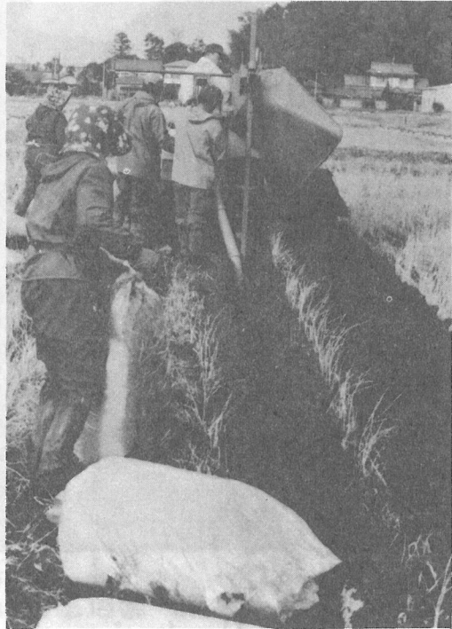
暗きょ排水工事 篠本三区地先
