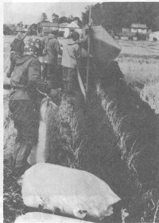
暗きょ排水工事 篠本三区地先
