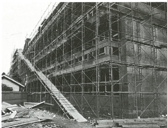
▶東陽小建設工事 (二ヶ年継続事業)
