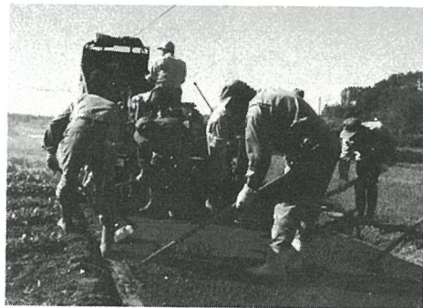
直営舗装工事 (篠本一区)
