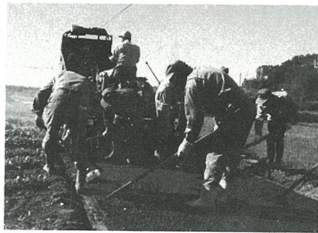
直営舗装工事 (篠本一区)
