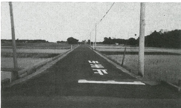
着々と進む道路舗装 (52年度完成・宮内～谷中線)
