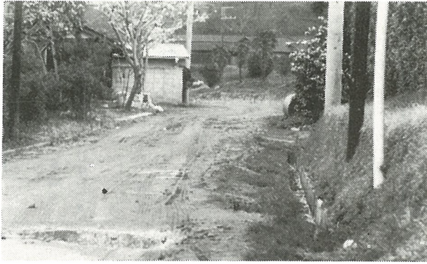
舗装工事が行われる宮坂線
