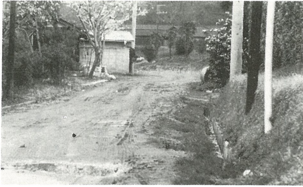
舗装工事が行われる宮坂線
