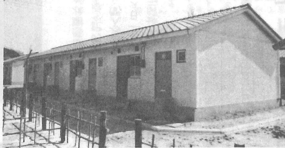
完成間近の小田部住宅
