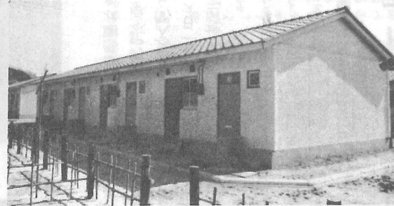
完成間近の小田部住宅
