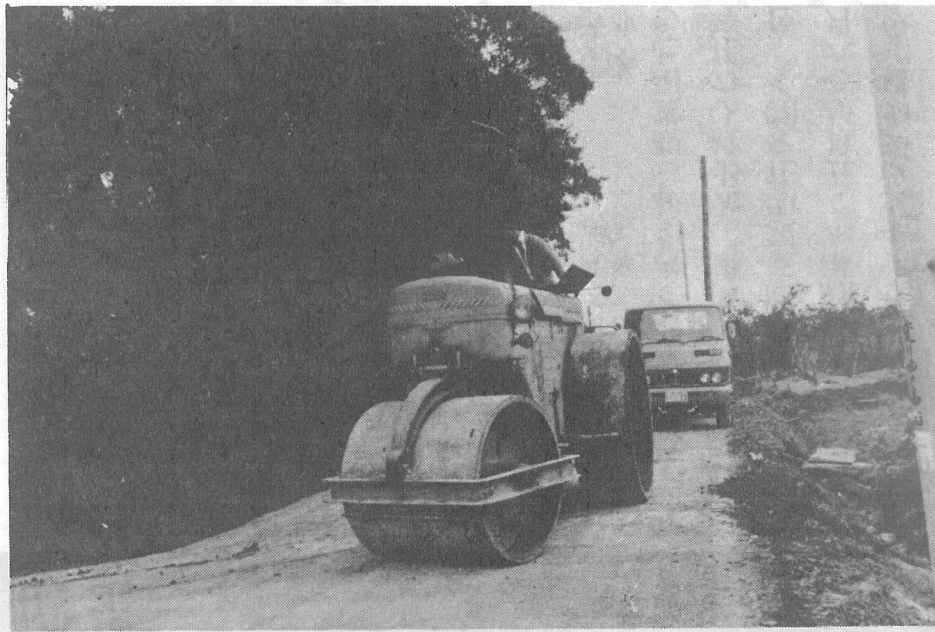
町道舗装急ピッチ
