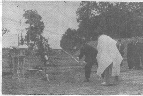
カブよくワク入れを行なう町長 —と畜場新築現場—
