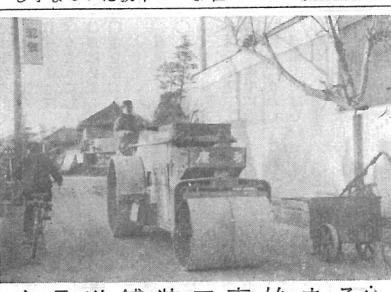
県道舗装工事始まる
