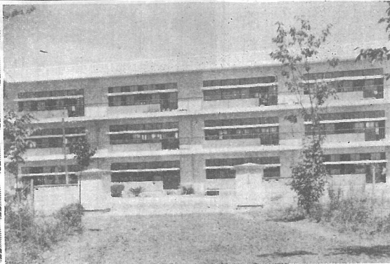
完成した光中校舎
