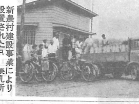
新農村建設事業による設置された日吉集乳所
