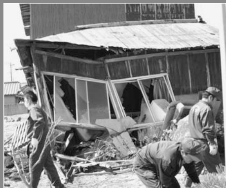
◀被災した家屋の撤去作業
