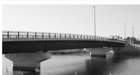
▲清長大橋が開通(平成28年)
