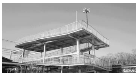
▲津波避難タワーが完成(平成27年)
