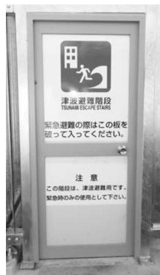
▲大津波警報などが発表されたときは、扉を破って屋上へ避難してください。
