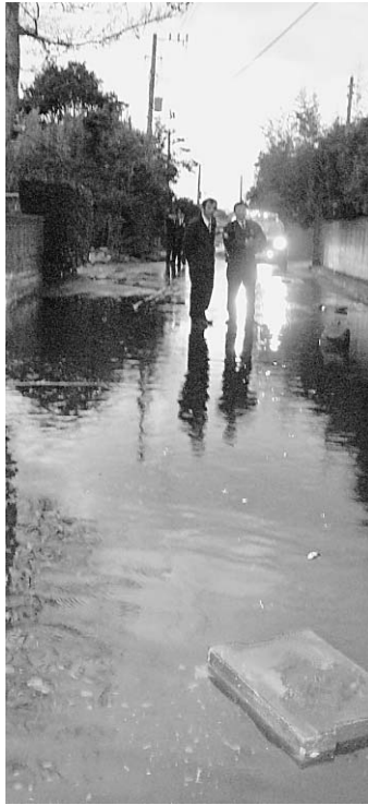
▲津波により浸水した町道
