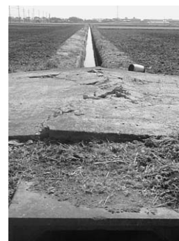
▲ひび割れた道路
