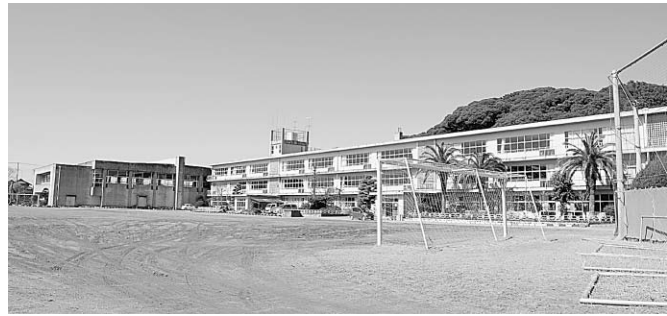
▲解体される横芝中学校旧校舎
