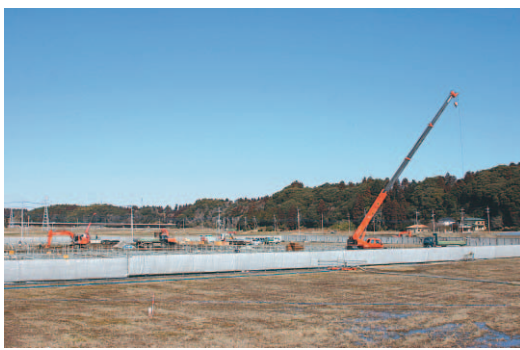
▶現在の建設現場(2月現在)
