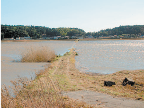
篠本新井地区の雨水被害
