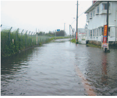
集中豪雨がもたらす道路冠水（屋形地区）
