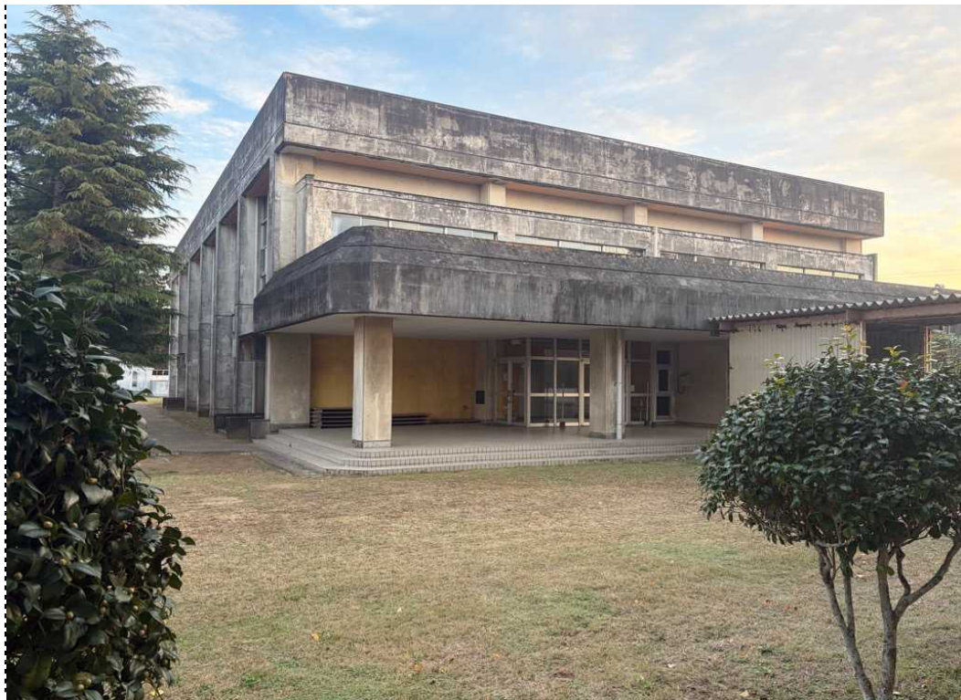
体育館(屋内運動場) 外観 撮影方向:北～南方向
