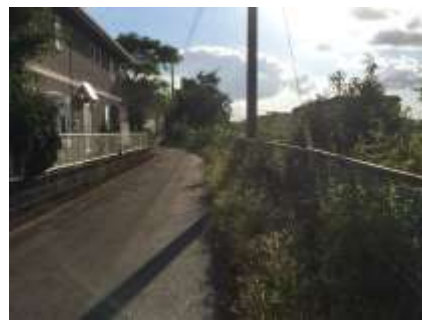
対象地と周辺住宅地の境界 1
