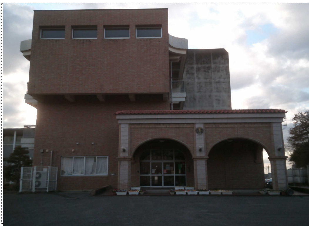
撮影方向:東～西方向
