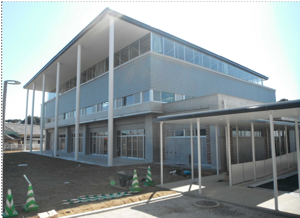
体育館(屋内運動場) 外観 撮影方向:東～西方向
