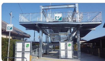
津波避難タワー
