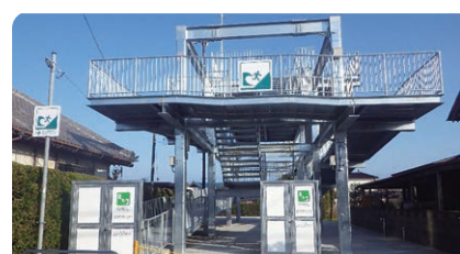
津波避難タワー
