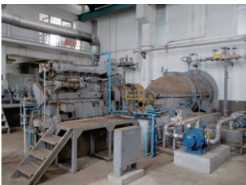
排水機場（更新前）
