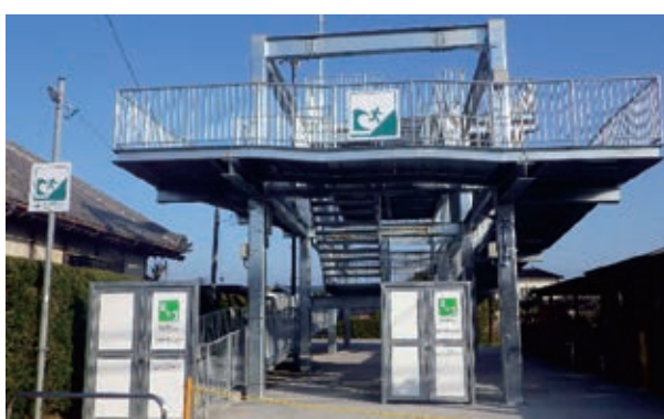
津波避難タワー
