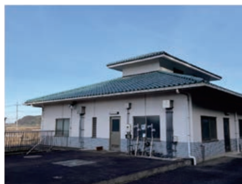
農業集落排水施設
