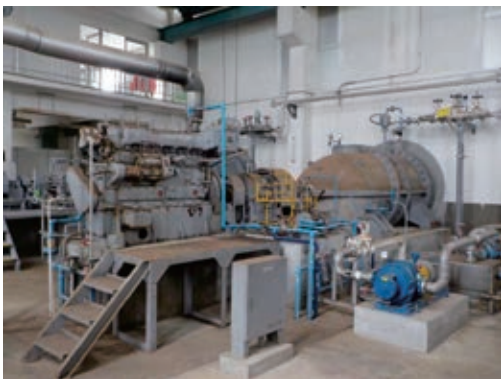
排水機場（更新前）
