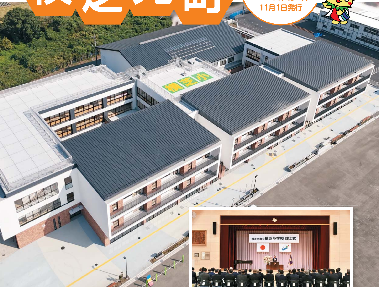
完成した横芝小学校新校舎
