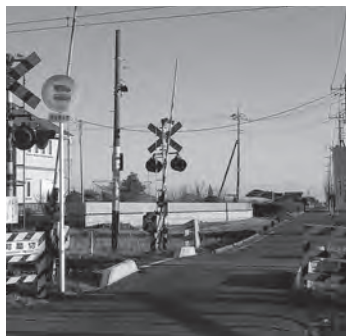
▲下町踏切（スーパーカスミ付近）
