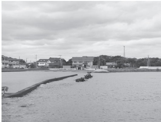
栗山川漁港嵩上げ現場
