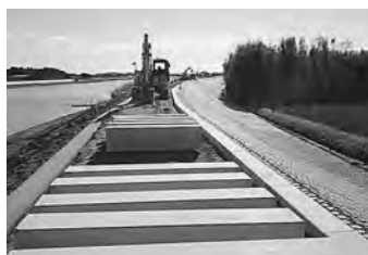
平成27年度までに完成予定の栗山川堤防の嵩上げ整備
