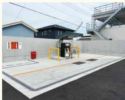
自家用給油取扱所
